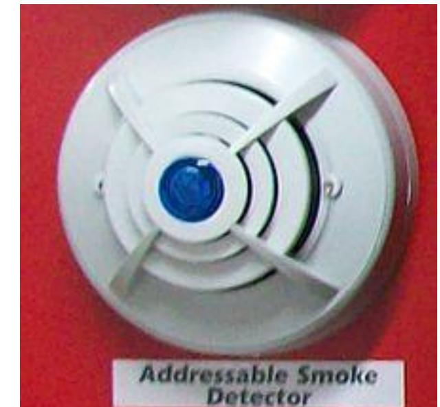
DIMNI DETEKTOR (JAVLJALEC POŽARA)
